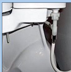
Brug medfølgende T-skykke, der skrues op i cisternen, vandtilførselslange samt slange til bidetsædet skrues på T-stykket.
