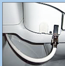
Den medfølgende slange skrues på indgangen til bidetsædet. Der åbnes igen for vandtilførsel.
