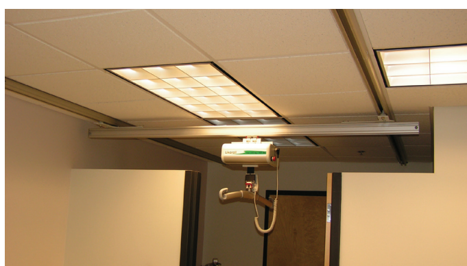
Sænkede badeværelsesvægge for at gøre plads til, at sekundær skinne kan passere
