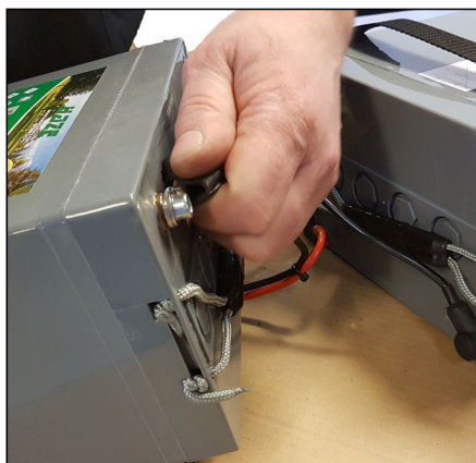
Afmonter polerne på de gamle batterier, og monter polerne på de nye.
